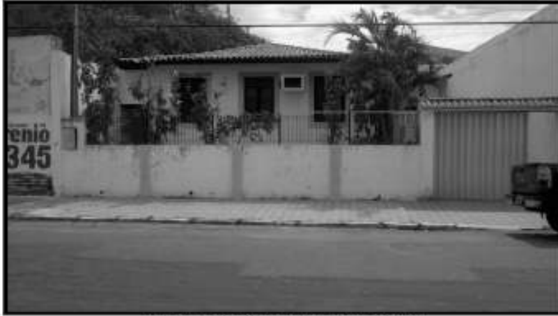
FOTO 03 – Vista frontal da casa a ser reformada.
