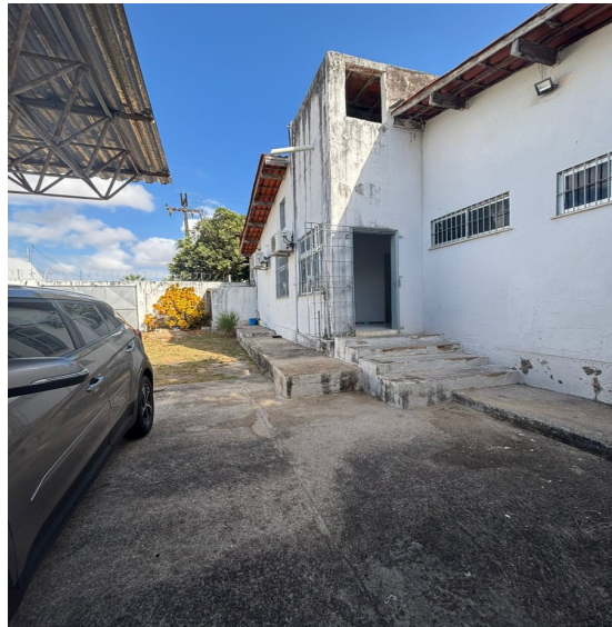
Porta de acesso ao Fórum pelo estacionamento
