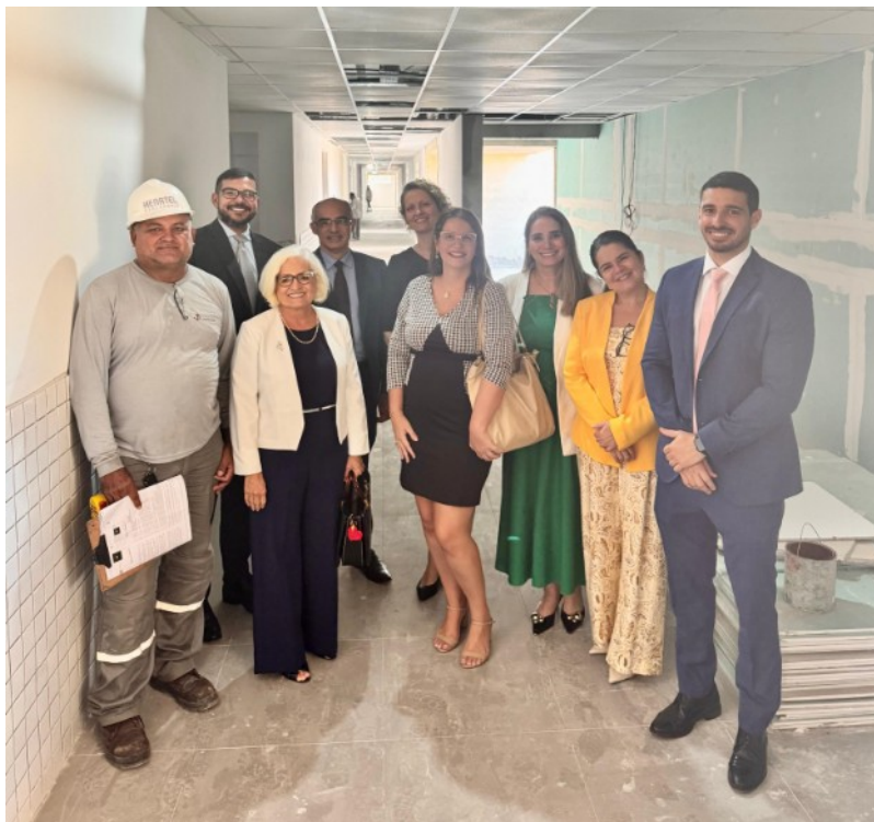
Obras do novo Fórum Ministro Jesus Costa Lima em 20/05/2025
