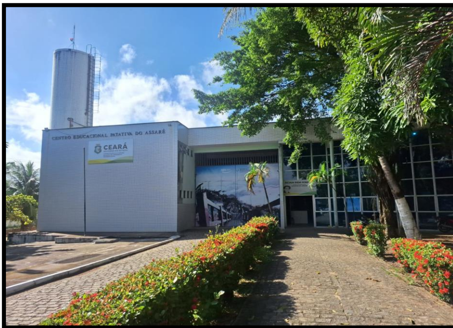
Acesso à entrada principal do Centro Socioeducativo Patativa do Assaré, em 15 de maio de 2026.
