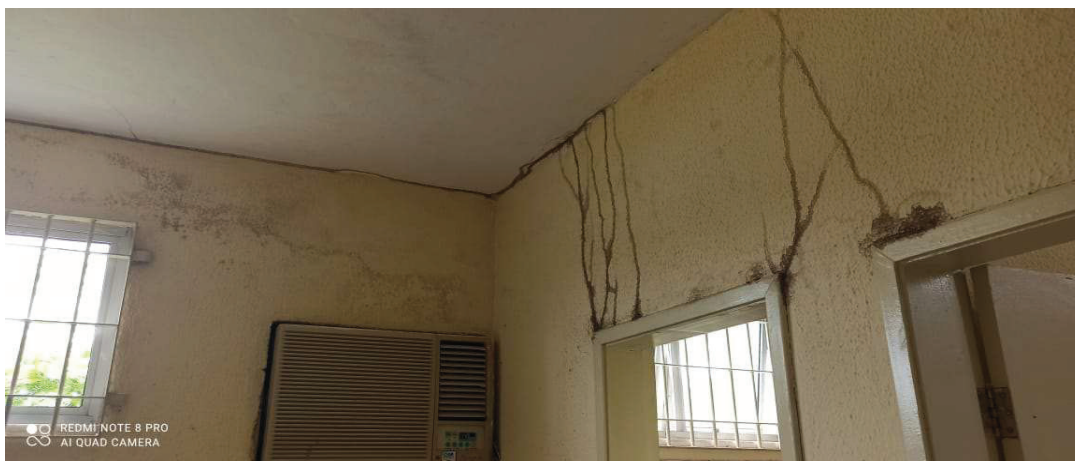
Figura 1: Imagem do gabinete do Juiz com cupins.
